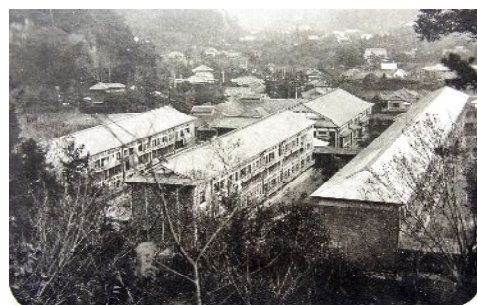
裏山より見下ろした、寄宿舎全景
